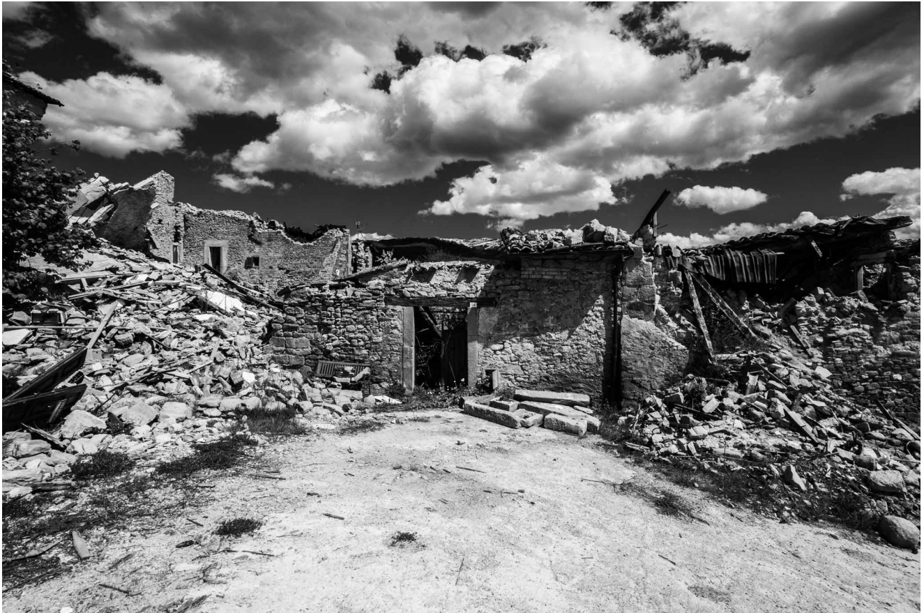
Figura 1 Accumoli, Lazio, uno dei centri più colpiti dai terremoti del 2016. Foto di Tommaso Della Dora (Quando la terra trema).
