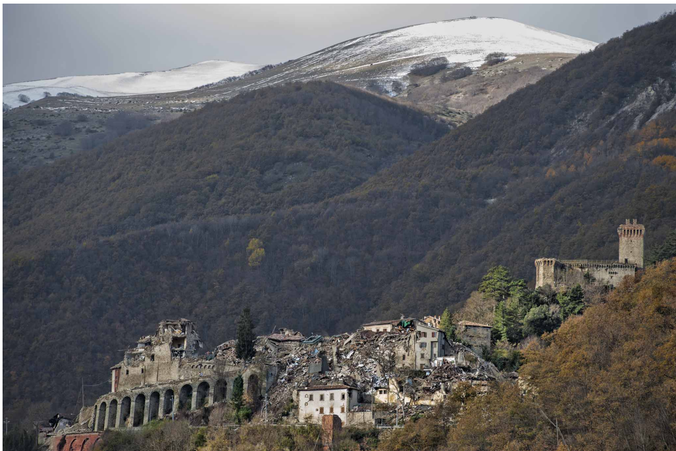
Figura 5 Arquata del Tronto dopo i terremoti del 2016. Un esempio di fragilità estrema, accentuata dal contrasto con l'imponente Rocca, edificata tra il XII e il XV secolo e ancora in piedi, sia pure danneggiata, al cospetto della maestosità e imperturbabilità dei Monti Sibillini. (Fotografia di Sergio Del Mese, 2016).
