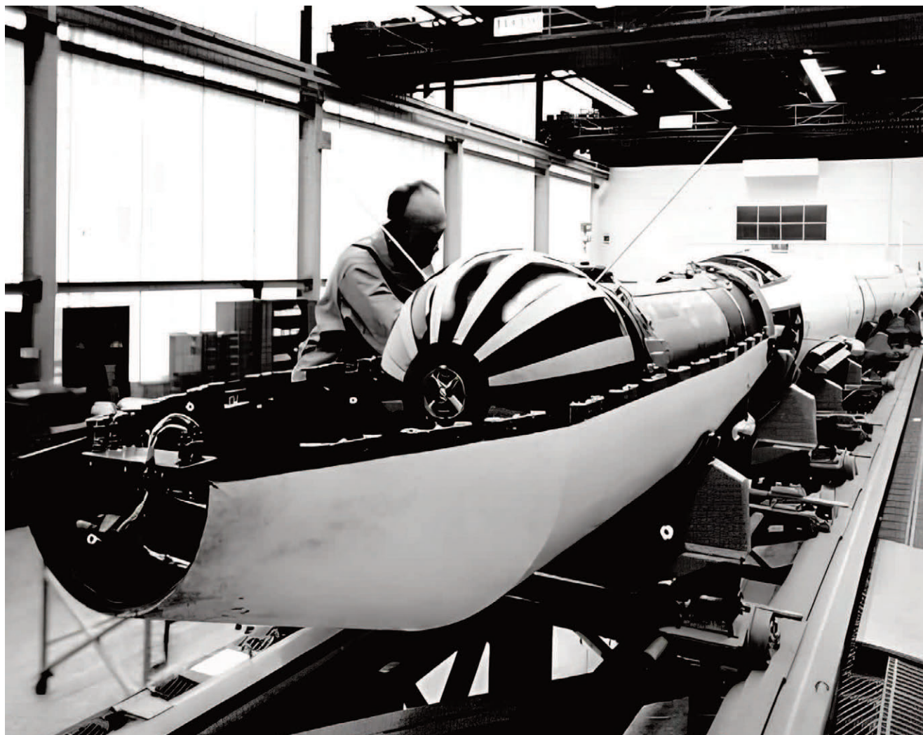
Figura 5 Alcune fasi dell'assemblaggio del San Marco 1 sul razzo lanciatore Scout. (Crediti: NASA).
