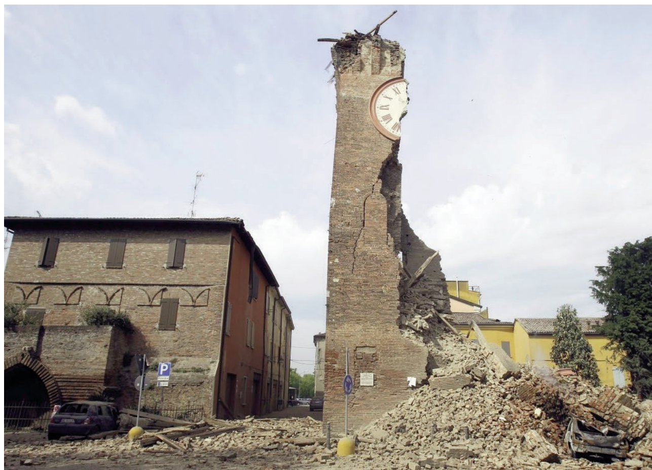
Figura 1 La Torre dell'Orologio di Finale Emilia (Modena) dopo il terremoto del 20 Maggio 2012. Figure 1 The Torre dell'Orologio of Finale Emilia (Modena) after the May 20th 2012 earthquake.
