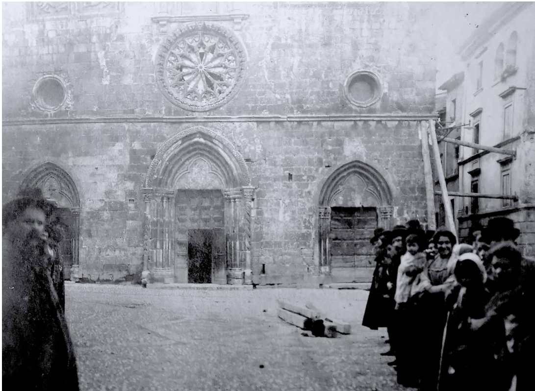
Figura 4 Facciata della chiesa di Santa Lucia a Magliano de' Marsi dopo il terremoto del 1904. Si noti il puntellamento del margine destro del prospetto e dell'adiacente fiancata. (Archivio Centrale dello Stato, Ministero della Pubblica Istruzione, Direzione Generale Antichità e Belle Arti, 3° versamento, 2a parte, b. 532, f. 6 "Aquila 1904-Magliano dei Marsi-Chiesa di Santa Lucia"; materiale fotografico in possesso dell'Archivio Centrale dello Stato, concessione del Ministero della Cultura, dichiarazione di utilizzo n. 2909/2024).
