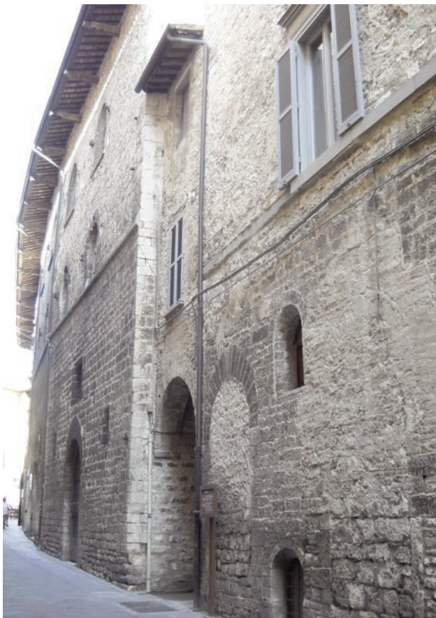
Figura 12 Gubbio, Via Cavour, imbocco di Via Toschi Mosca: arco di rinforzo costruito dopo il terremoto del 1751 tra i palazzi Bentivogli e Beni (foto di E. A. Sannipoli).
