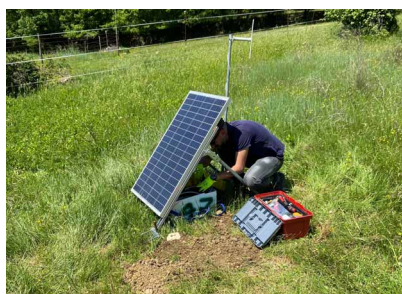
Figura 10 Foto della stazione T1647, installata in località Greti (Greve in Chianti), durante le operazioni di manutenzione. Alle spalle dell'operatore, è visibile il supporto dell'antenna ad alto guadagno per la trasmissione dei dati in real-time che confluiscono nel sistema di monitoraggio nazionale dell'INGV (foto di Damiano Biagini). Figure 10 Picture of the T1647 station installed in Greti (Greve in Chianti), during maintenance operations. Behind the operator, the high-gain antenna support is visible for the transmission of data in real-time that flows into the INGV national monitoring system (photo by Damiano Biagini).
