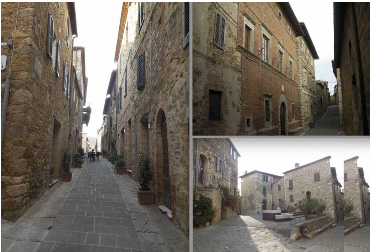
Figura 1 Edifici a Castelnuovo dell’Abate (SI) [foto Marco Falorni, 2022].
