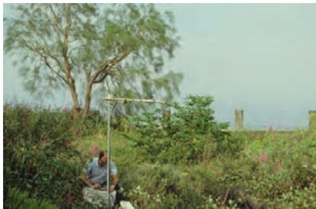
Figura 56 Verifica dei parametri impostati sulla stazione Lennartz PCM 5800 installata in località Emmaus, Zafferana Etnea (foto G. Vilardo).
