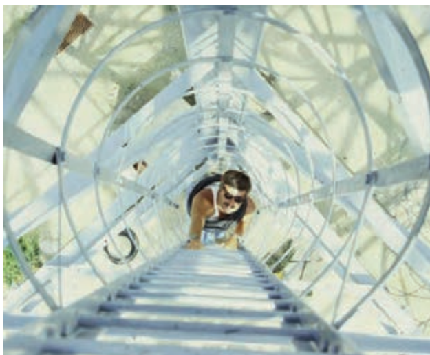
Figura 65 Operazioni per l'installazione delle antenne di ricezione su una piattaforma del traliccio SIP (foto G. Vilardo). Figure 65 Installation procedures of the receiving antennas on the SIP pylon (photo G. Vilardo).
