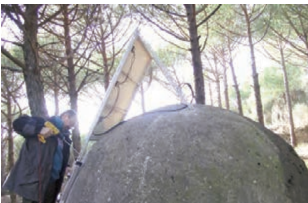
Figura 74 Installazione dei pannelli solari e passaggio cavi presso il sito di Bunker Sud, Riserva Naturale "Tirone Alto Vesuvio" (foto M. Capello).
