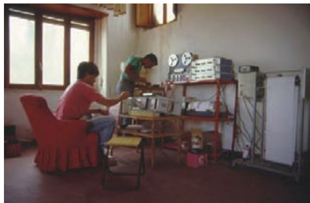
Figura 60 Catena di decodifica del sistema Lennartz PCM 5800 installata presso la centrale di acquisizione di San Gregorio (foto G. Vilardo). Figure 60 Lennartz PCM 5800 decoding system installed at the acquisition center of San Gregorio (photo G. Vilardo).
