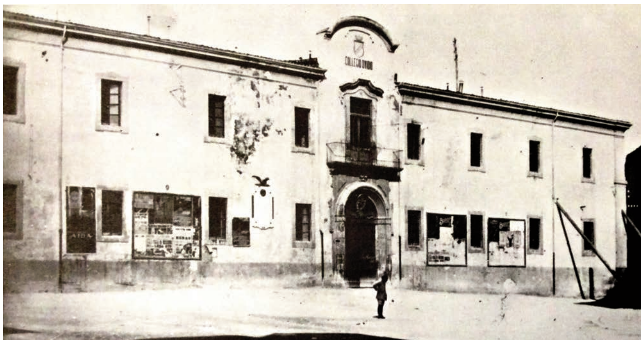
Figura 18 Puntellamenti sulla facciata del Collegio Ovidio, in Piazza XX Settembre [da Mattiocco, 1972]. Si tratta di interventi probabilmente dovuti agli effetti del terremoto del 1915.
