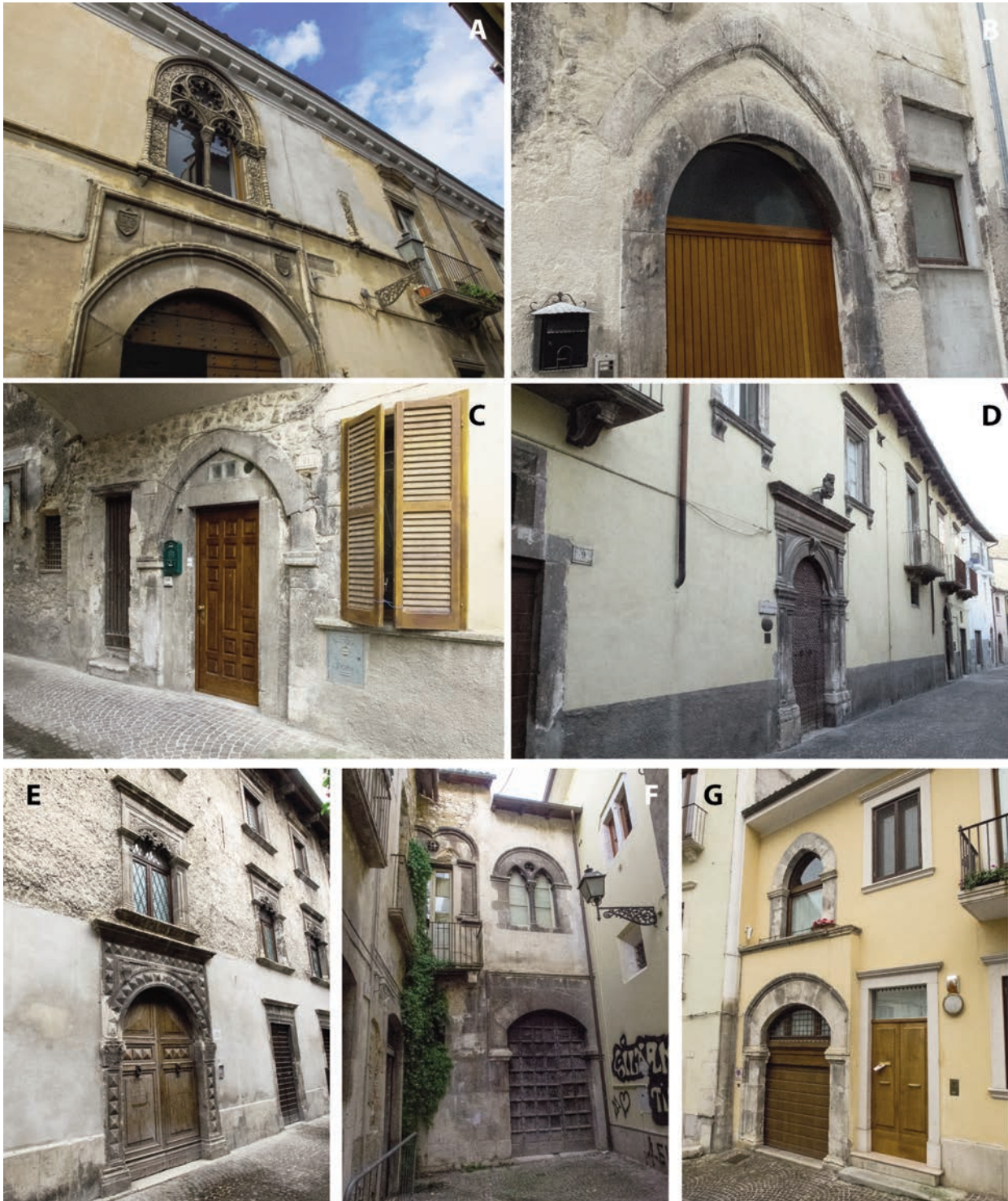
Figura 5 Elementi architettonici preesistenti al terremoto del 1706 (si veda la figura 1 per l'ubicazione): a) Settore superiore della facciata del Palazzo Tabassi in via E. Ciofano; b) via Acuti; c) via G. Quatrario; d) Palazzo Capograssi in via Papa Innocenzo VII; e) Palazzo Liberati in via Peligna; f) Palazzo Sanità in corso Ovidio (tratto settentrionale); g) Largo Mazara.
