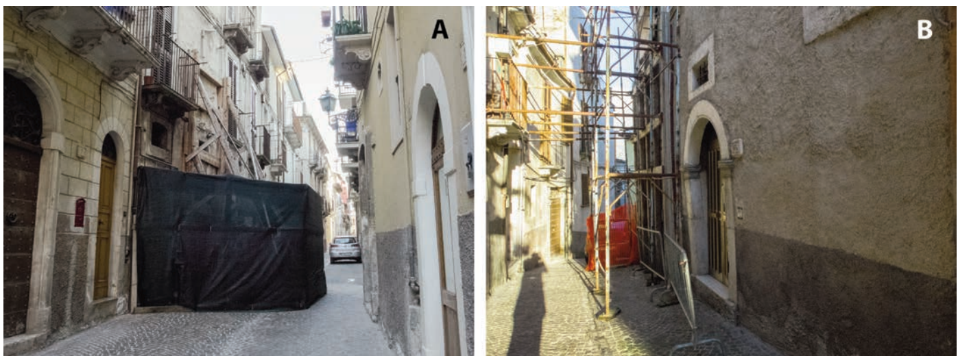
Figura 20 Puntellamenti in via Probo Mariano (A) e in vico Cascile (B) (si veda la figura 1 per l'ubicazione).
