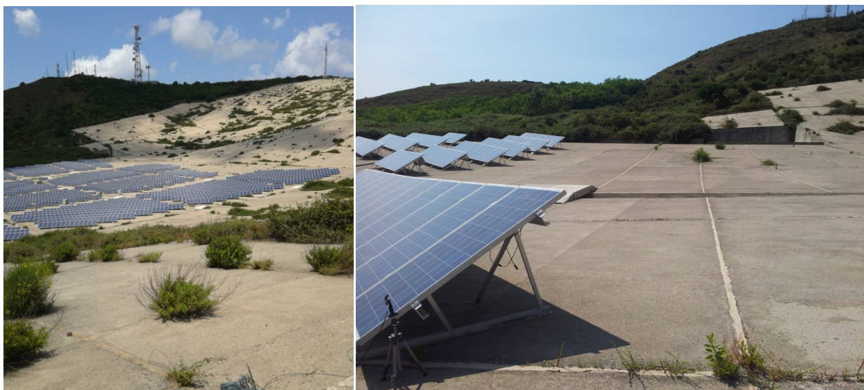
Figura 4. La riserva idrica di Monte S. Angelo, chiamata “Reservoir”.
