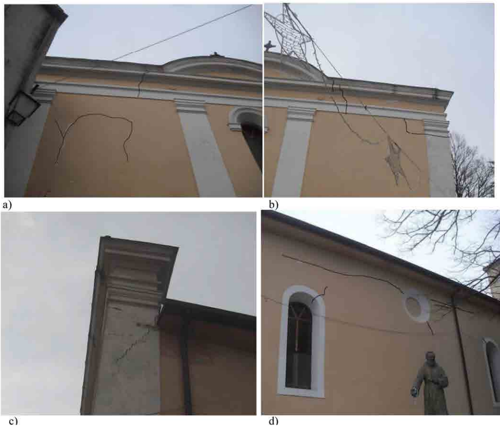
Figura 18. Chiesa San Giovanni Battista. Lesioni sulle facciate livello di danno D2-D3-Medio-Grave. Le lesioni delle foto a), b) e d) sono state evidenziate.
