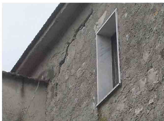
Figura 20. Danni ad un edificio in località Petrito. L'edificio presenta danni pregressi per cedimenti fondali. Livello di danno D3-Grave.
