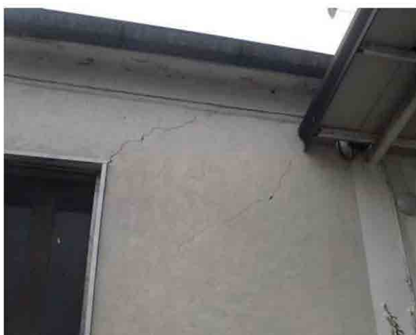
Figura 20. Danni ad un edificio in località Petrito. L'edificio presenta danni pregressi per cedimenti fondali. Livello di danno D3-Grave.
