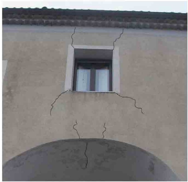
Figura 13. a) Convento S. Maria Occorrevole (San Pasquale). b) Lesioni arcata di ingresso. Livello di danno D2-D3-Medio-Grave. Le lesioni sulla foto b) sono state evidenziate.
