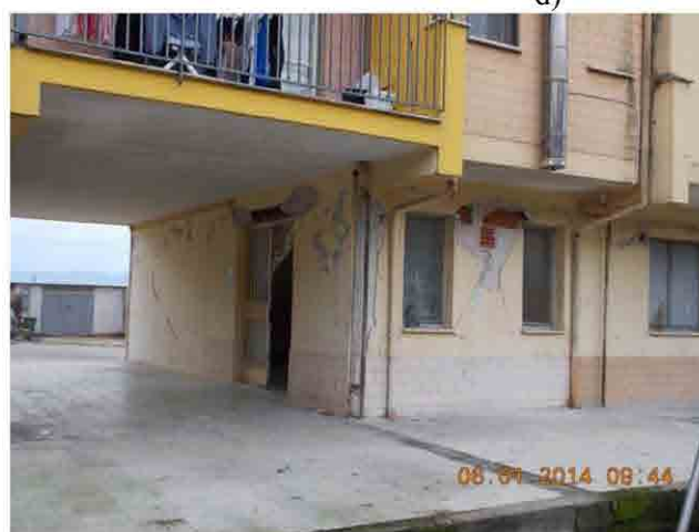
Figura 10. Via Aldo Moro, Condominio II. Lesioni alle tamponature edifici c.a. con tipologia Pilotis. Lesioni in a), b) e c) livello di danno stimato D2-D3-Medio-Grave. Lesioni in d) ed e) livello di danno stimato D3-D4-Grave-Gravissimo. Nell'ambito dell'agglomerato edilizio si nota una riduzione dei danni in direzione Nord-Ovest.
