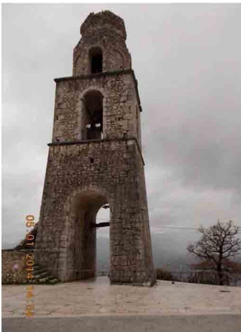
Figura 14. Torre campanaria Santuario S. Maria Occorrevole (San Pasquale, quota 500m s.l.m.). Caduta pietre dalla Torre, livello di danno D2-D3-Medio-Grave.
