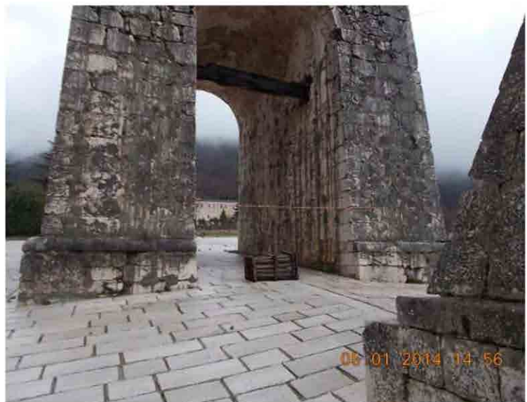
Figura 14. Torre campanaria Santuario S. Maria Occorrevole (San Pasquale, quota 500m s.l.m.). Caduta pietre dalla Torre, livello di danno D2-D3-Medio-Grave.
