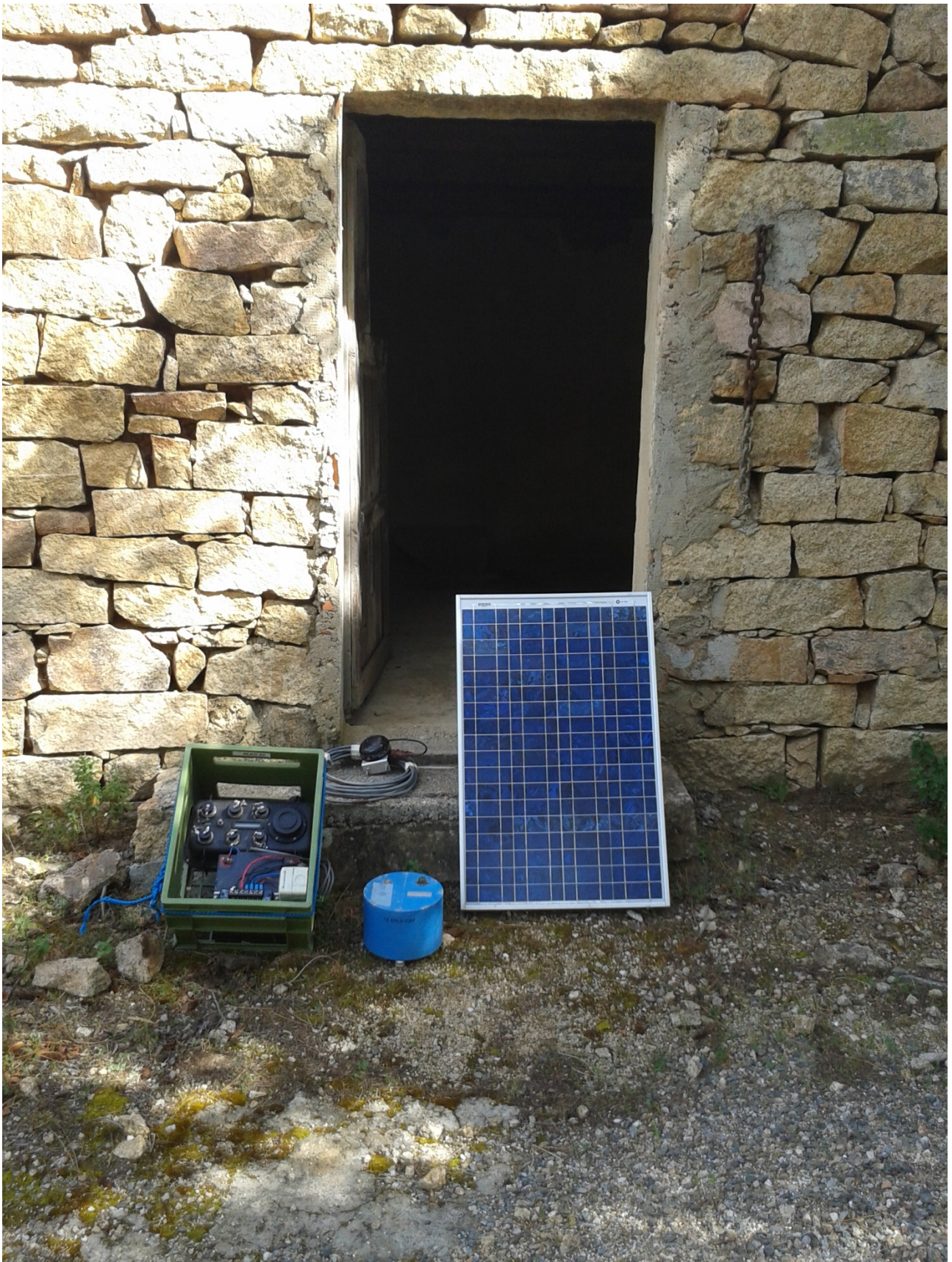
Figura 3. Strumentazione tipo installata nei siti della rete temporanea. L'esempio è relativo alla stazione SPA05 ubicata nella Foresta Demaniale di Usinavà nel comune di Torpé (NU).
