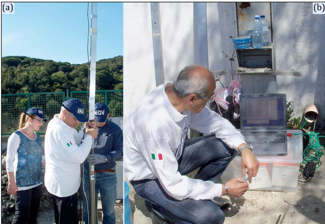
**Figura 26.** Controllo dell'azimuth durante l'installazione. (a) Foto relativa al sito ISC. (b) Foto relativa al sito BRN.
