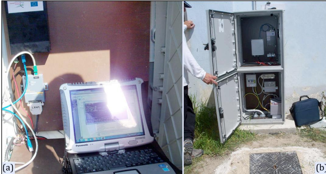
**Figura 29.** Collegamenti per lo scarico dati. (a) Foto relativa al sito HDM. (b) Foto relativa al sito FOR.
