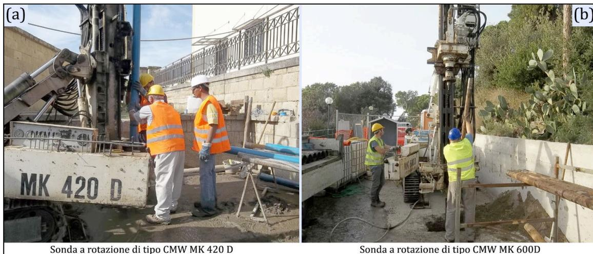
**Figura 11.** Sonde utilizzate nelle fasi di scavo dei sondaggi. (a) Foto relativa al sito CMP. (b) Foto relativa al sito HDM.
