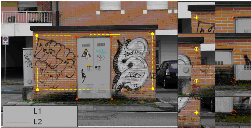
Figura 1. L'oggetto del rilievo è una cabina di impianti e servizi di piccole dimensioni. La facciata misura circa 4 m x 2.5 m. La porta ha una cornice con perimetro di circa 6.27 m; i mattoni hanno una lunghezza di circa 24 cm e altezza di 5 cm. Le fughe sono, mediamente, di circa 1 cm. Sulla facciata vi sono dei dettagli geometrici (spigoli e mattoni) e graffiti che creano aree nettamente riconoscibili nelle immagini.
