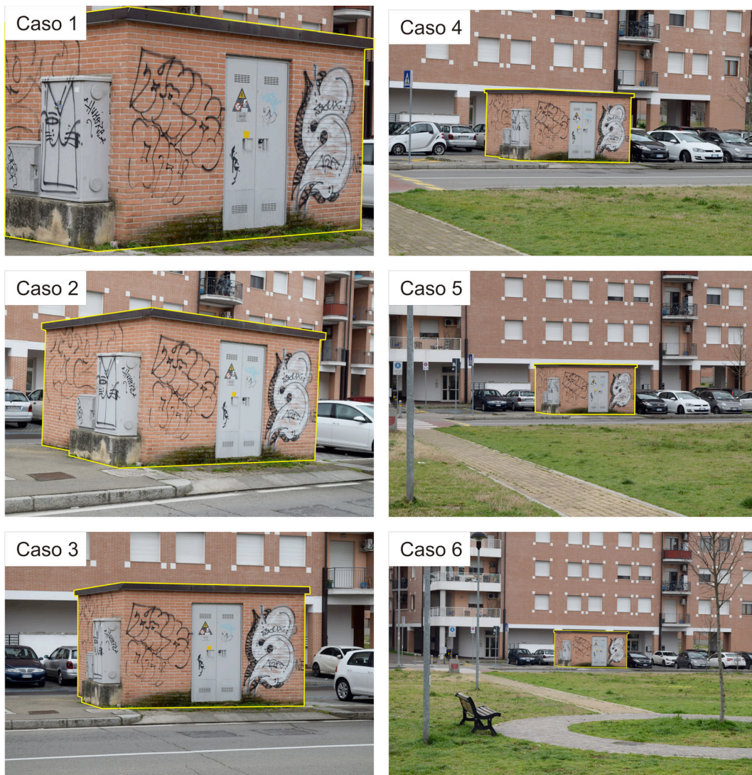
Figura 3. I frame acquisiti dalle varie distanze (caso N : la distanza, in metri, è 10N ). Si noti come l'area di interesse ricopra via via un'area sempre più piccola nell'immagine. In giallo è indicata l'area selezionata per il trattamento dati SfM.
