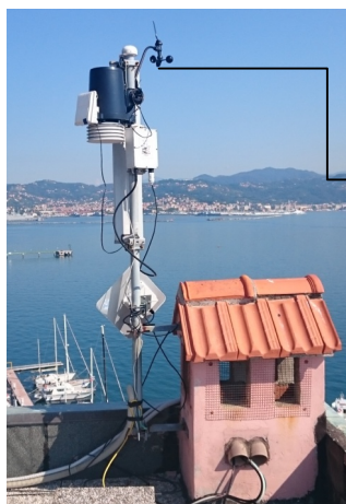
Figura 17. Stazione meteorologica; installazione presso la sede INGV di Porto Venere.
