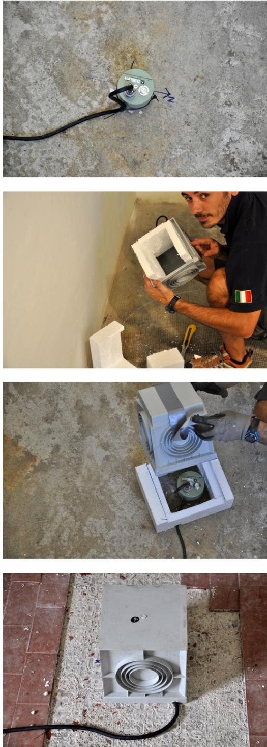
**Figura 5.** Esempio di come sono stati protetti i sensori a larga banda *Trillium 120c* nell'installazioni EASI. Per garantire una temperatura tendenzialmente costante durante tutto il periodo dell'acquisizione, i sensori sono stati disposti all'interno di locali protetti da una struttura mista di polistirolo e plastica.
