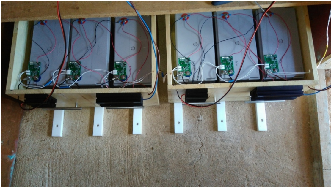
Figura 16. Foto dell'installazione del BGG presso l'Osservatorio i eomagnetico di Lampedusa.
