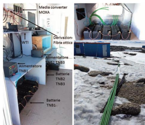
**Figura 8** A sinistra, immagine dello shelter acquisizione. Sono visibili in basso le batterie dei tre sistemi, gli alimentatori lineari, il dispositivo per la gestione delle alimentazioni da remoto WTI, i media converter e le scatole di derivazione delle fibre ottiche. A destra un'immagine del dettaglio delle batterie del sistema TNB1 con la scatola di derivazione dei cavi di alimentazione e un'immagine dei nuovi cavi di alimentazione e comunicazione per gli altri due shelter.
