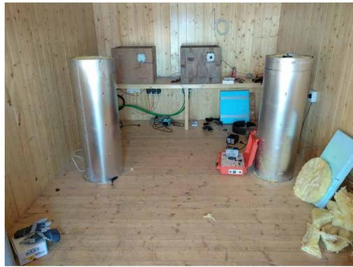
**Figura 3** Magnetometri nello *shelter* strumentazione durante l'esecuzione dei lavori di installazione.
