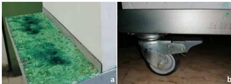
**Figura 4** Particolari della base esterna della casa: a) area giardino della casa b) ruote piroettanti sottostanti la base.
