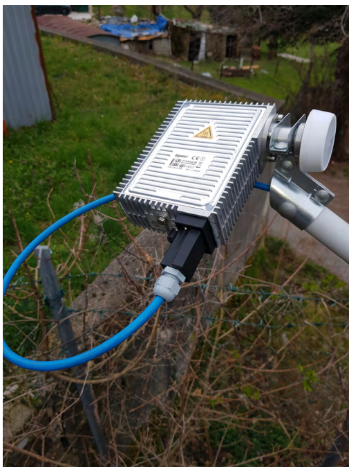
Figura 18 Prima installazione in sito del cappuccio.
